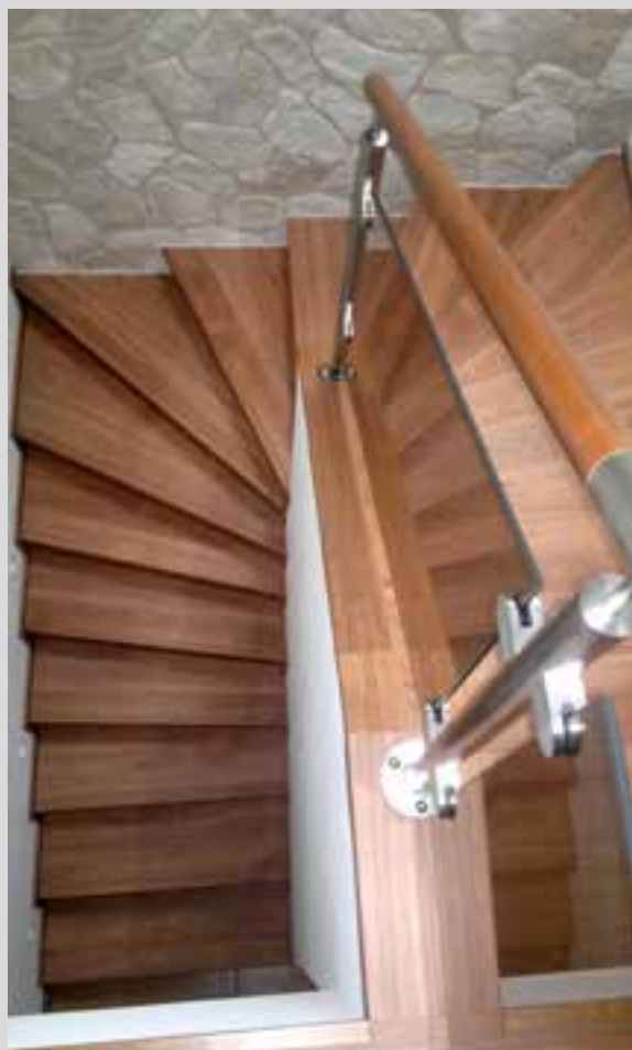
Realizace schodiště z vinylu.
