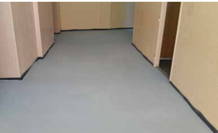
Správně udělaná nivelace – suchá.
